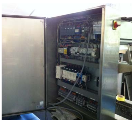
Ajout d'une armoire électrique inox
